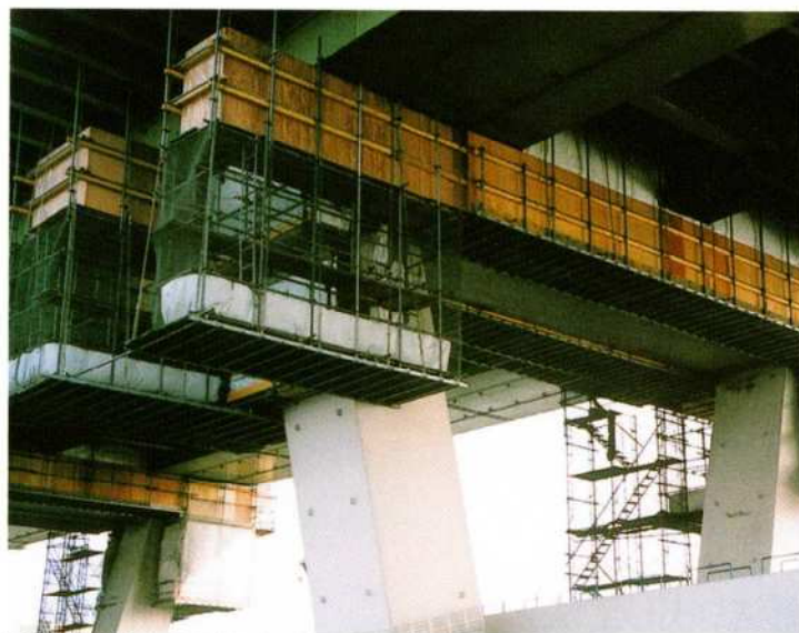
阪神高速道路公団 支承取替工事
