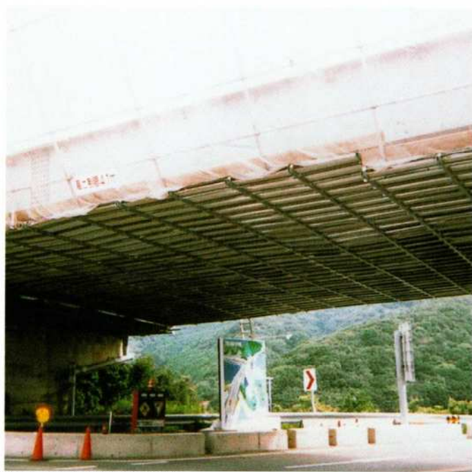
建設省 伊古木高架橋(コンパネ仕様)
